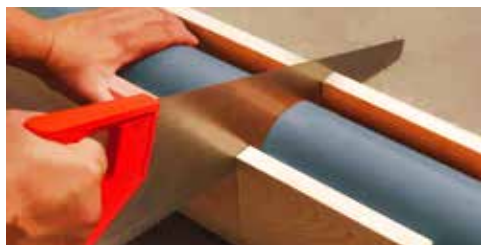
Obrázek 1 Zkracování trubky pilkou
